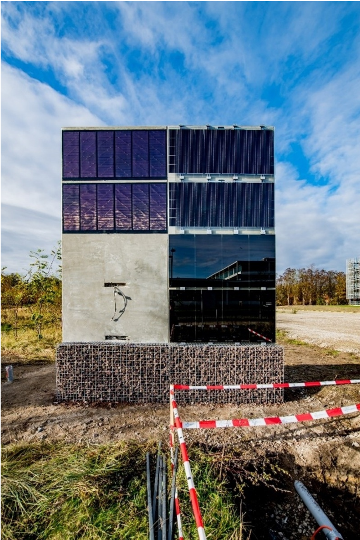
Geluidsschermen met geïntegreerde zonnepanelen tonen hun grote energiepotentieel
